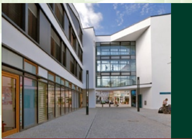
Verwaltungszentrum Barnim, GAP Architekten, Berlin
