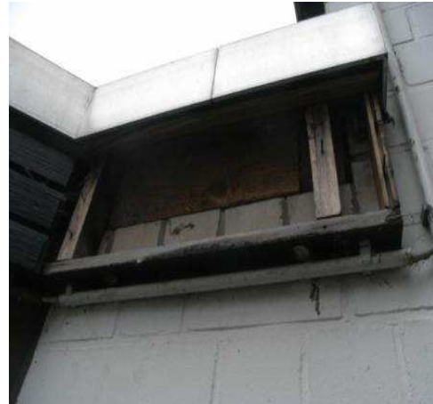
Mangelhafte Dämmung
