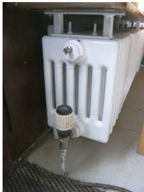
Ist-Zustand in der Kita
