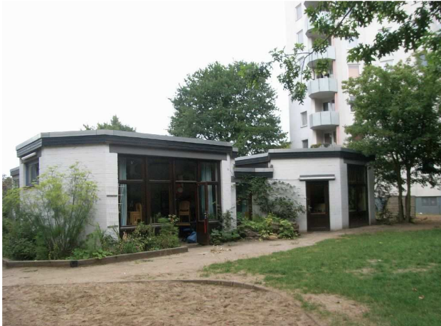
Ansicht Rückseite, Holz-Glas-Elemente
