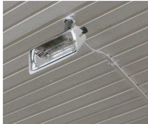
Defekter Halogenstrahler
