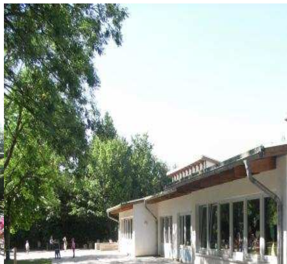
Fassade mit Dachaufbau
